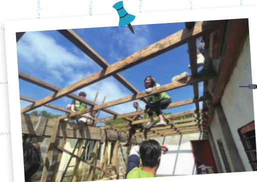
마우 마을 창고 건설
